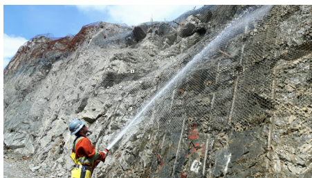
► La restauration du portail de la rampe d'exploration du projet Lac Windfall est terminée.
